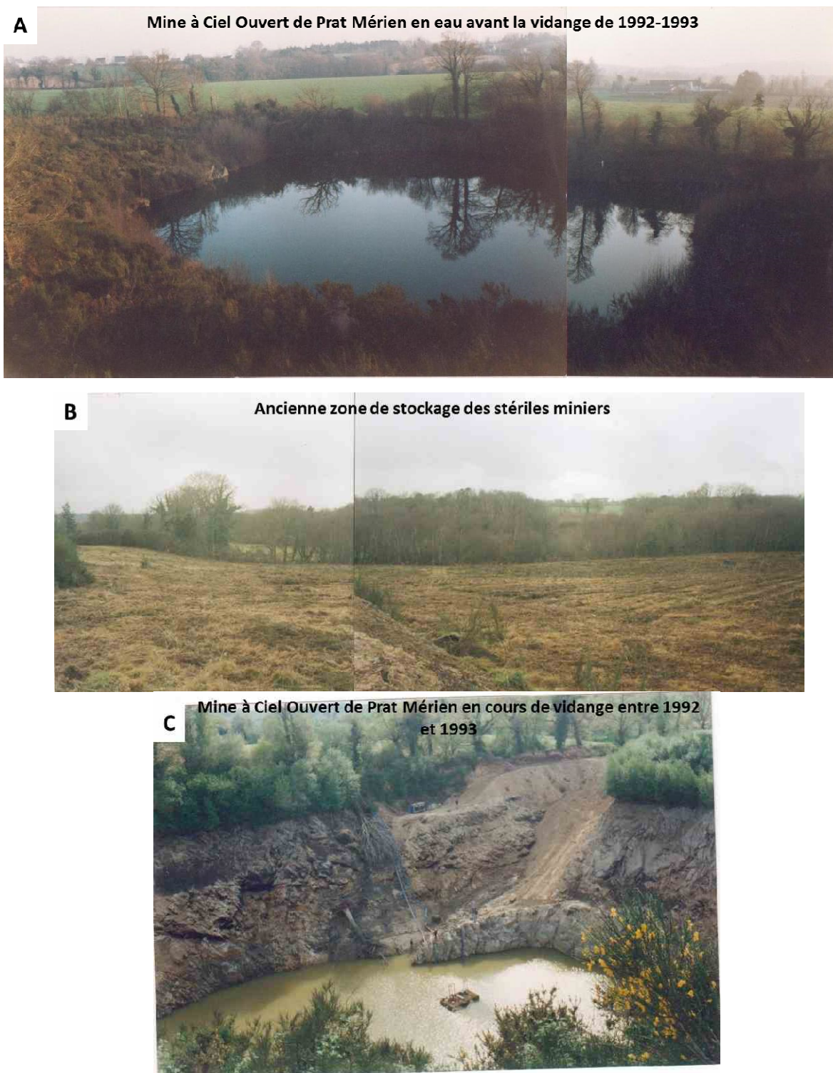
Figure 34 : Photographies des travaux miniers de Prat Mérien avant et en cours de réaménagement ; A- MCO de Prat Mérien en eau, B-Zone de stockage des stériles miniers après réaménagement de la MCO et décaissement de la zone, C- MCO de Prat Mérien en cours de vidange (source M. Jarno)
