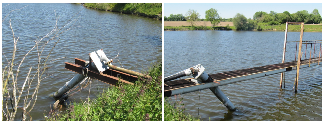
Figure 21 : Lignes de prélèvement de la station de pompage de l'eau de la MCO du site de La Godardière
