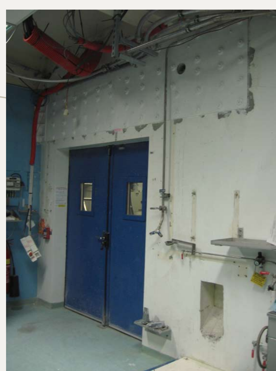
Renforcement d'un linteau. © CEA
